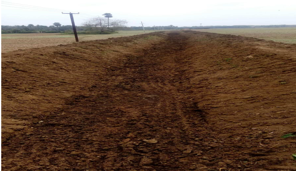
Renovation Work of Sirlo Brmhanakhanda Drain ( Nischintakoili)
